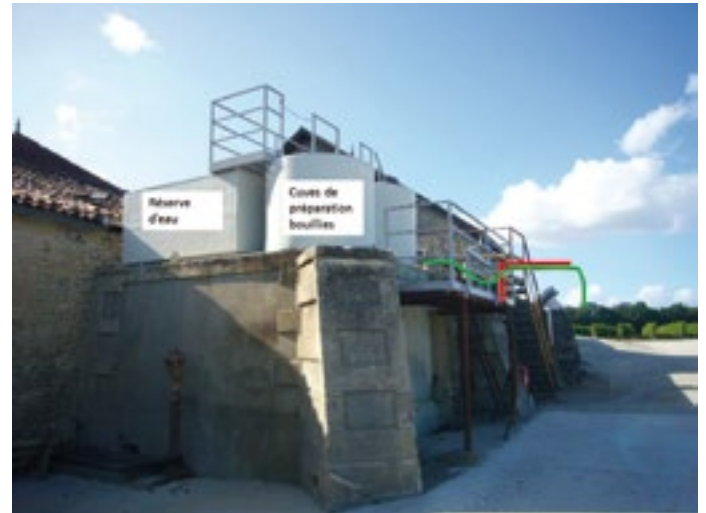
Aire phytosanitaire : cuves d'incorporation et de préparation phytosanitaire
